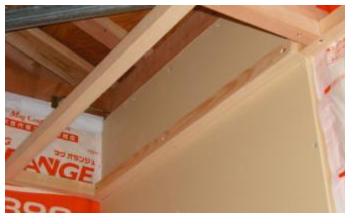
気密テープによる防湿フィルム耳かけ部分の耳押さえ(4地域以南)
