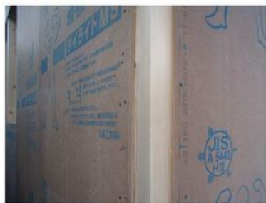
①構造用合板等の面材を施工します。
