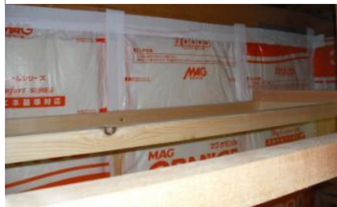
気密テープによる防湿フィルム耳かけ部分の耳押さえ(4地域以南)
