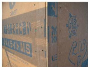
②出隅へふかし材として面材を施工します。
