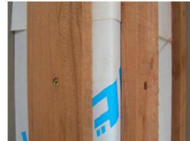
④専用ビスで通気胴縁を取り付けます。
