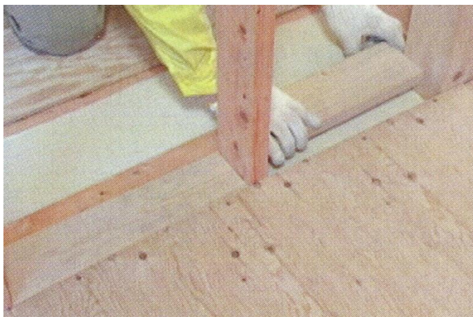
乾燥木材による気流止め
