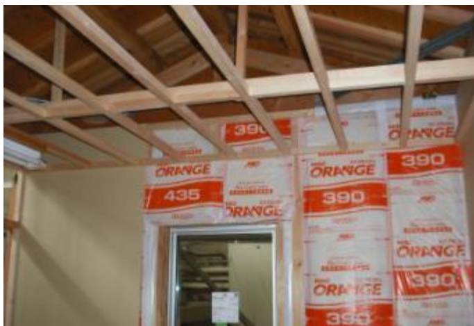
乾燥木材による防湿フィルム耳かけ部分の耳押さえ
