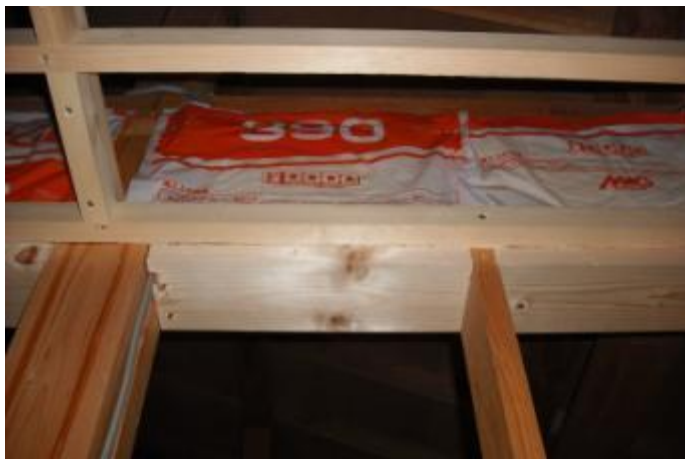
乾燥木材による気流止め
