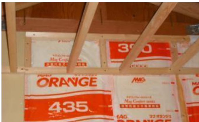
乾燥木材による防湿フィルム耳かけ部分の耳押さえ
