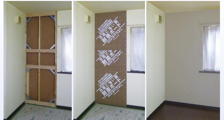
内壁補強キットの施工例
