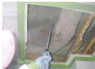
部分除去作業
