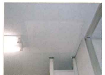
仕上げ復旧後
