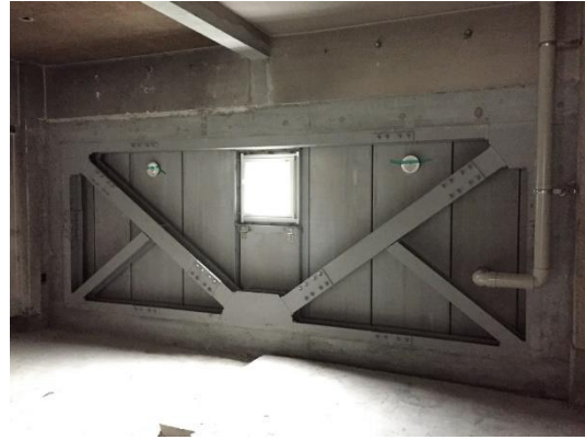
構面内の枠組耐震ブレース補強
