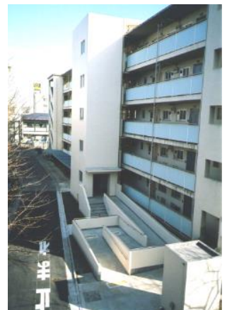
スロープの設置
