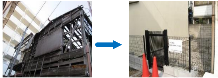
【老朽空き家を除却し防災広場を整備（資料提供 墨田区）】
