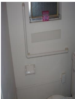
手すりの設置
