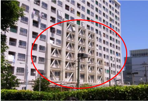
外付け耐震ブレース補強
