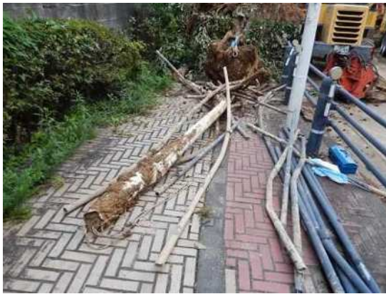
写真 4 破損した街路灯やガードパイプ
