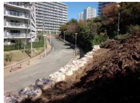
写真 2 並べられた土のう
