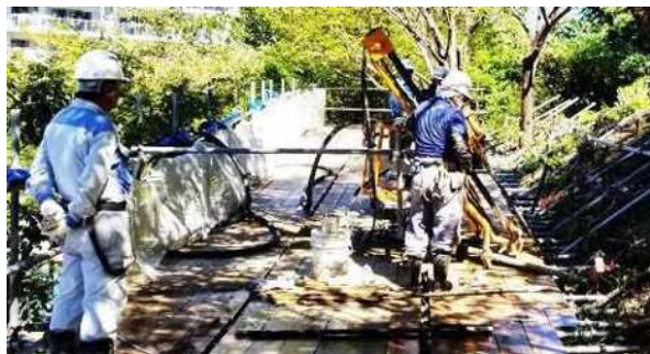
写真10 削孔状況
