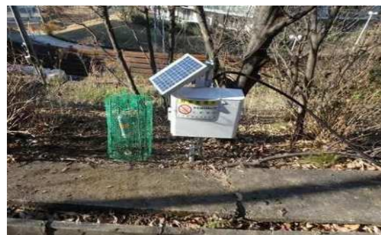
写真7 地盤傾斜センサー
