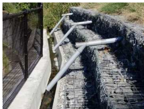
写真9 横ボーリング工完了
