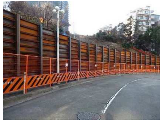
写真 5 仮設防護柵（交通開放時）
