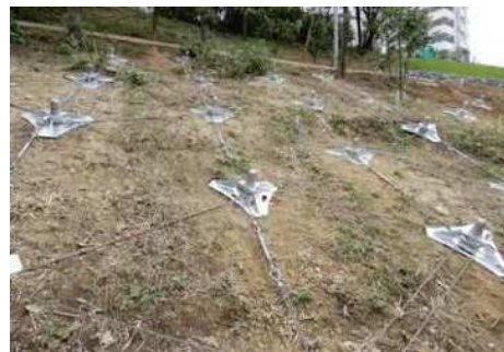
写真11 地山補強工完了
