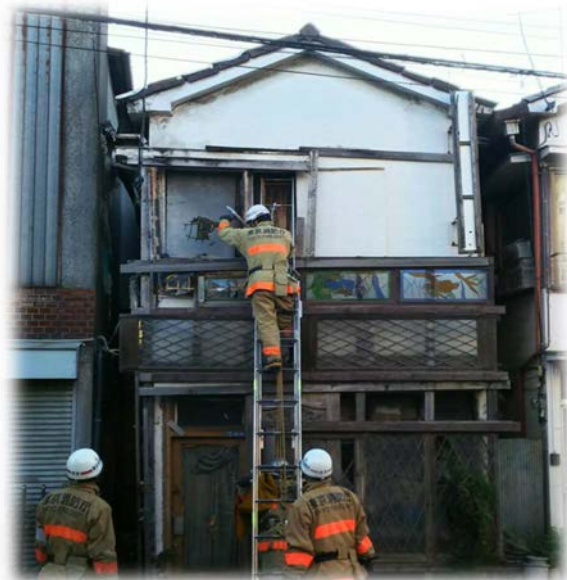
図8 消防隊による緊急避難措置の様子
