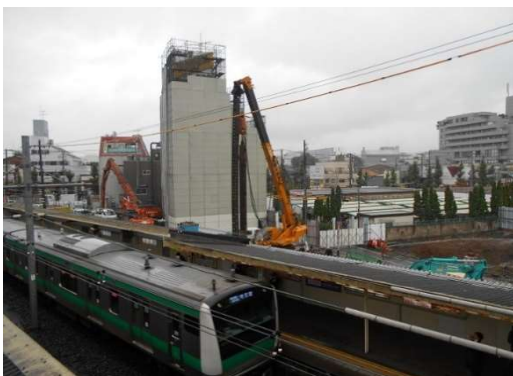
図1 現在の十条駅周辺の状況
