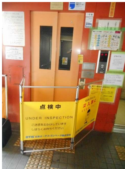
図3 安全柵の設置
