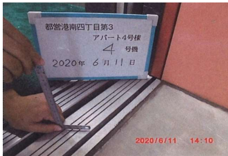
図11 点検写真撮影(かごと乗場床レベル点検)
