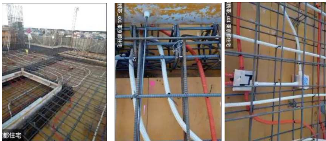
図22 配管検査の配信映像抜粋
