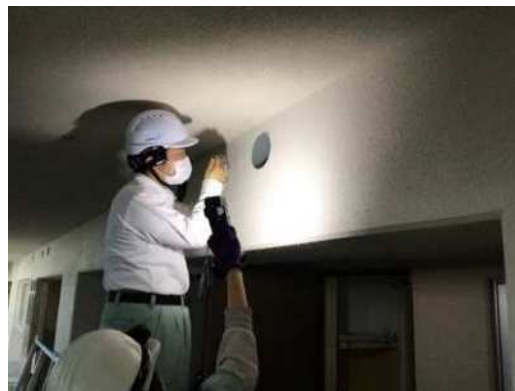
図 17 遠隔施工状況確認の様子
