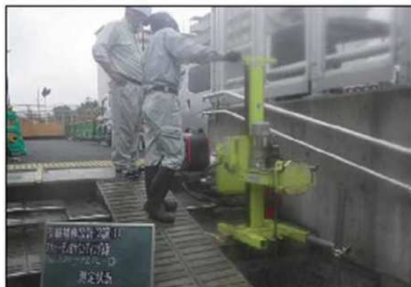
写真 4 SS 試験実施状況写真
