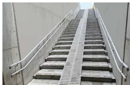
写真9 補修完了後開放写真
