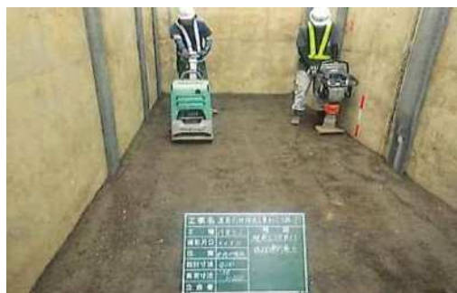
写真8 埋戻し施工状況写真
