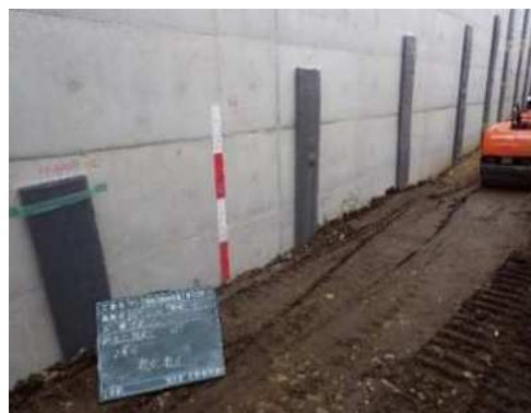
写真6 埋戻し施工状況
