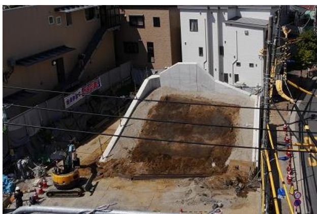
図7 再建前の塚の土を保全（馬蹄型コンクリート）
