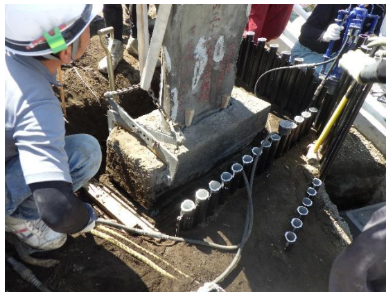
図6 石碑の固定・設置
