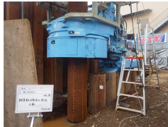
図8 杭の打設
