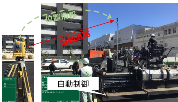
写真 7 MC アスファルトフィニッシャー
