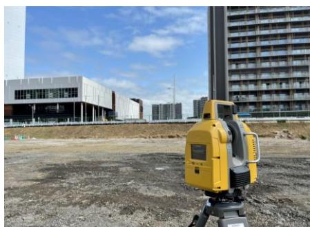
写真1 TLSによる測量状況
