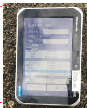
写真6 リアルタイムでの出来形確認
