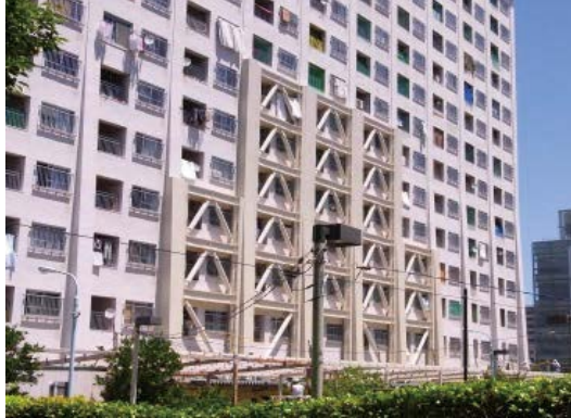
外付け耐震ブレース補強
