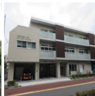
障害者支援施設（世田谷区）
