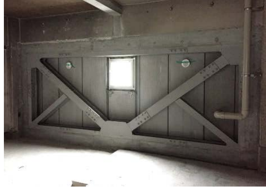
枠組耐震ブレース補強
