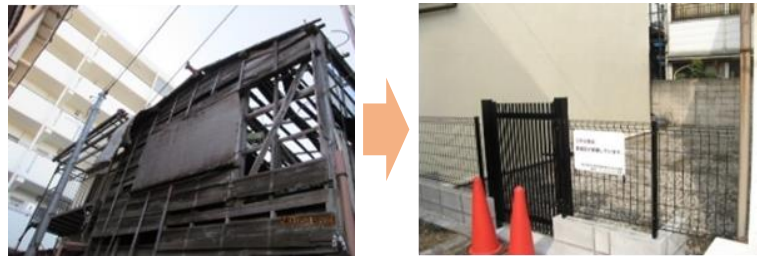
図表 26 除却跡地を防災空地として活用した例
