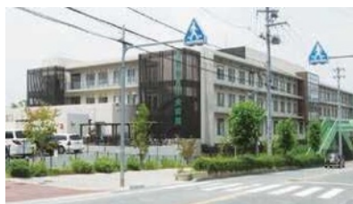
西奈良中央病院（鶴舞/奈良県奈良市） 敷地
