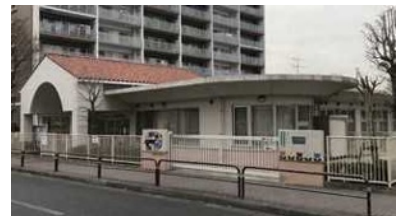
東村山市立第四保育園(グリーンタウン美住一丁目/東京都東村山市) 敷地
