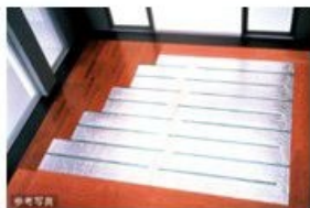
床暖房設備 足下から暖める温水式床暖房を設置
