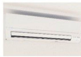
省エネエアコン 省エネルギー仕様のエアコンを各住戸に一台設置
