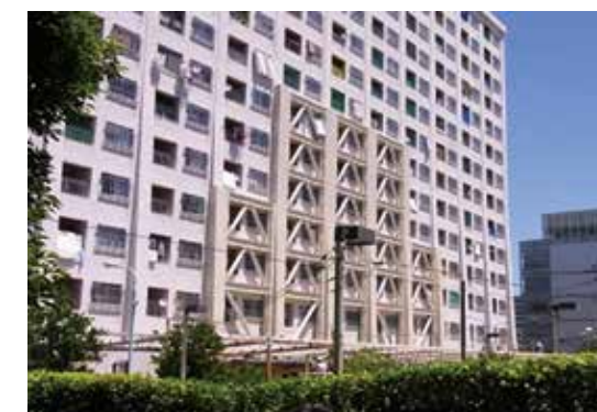
都営住宅の耐震化の例 (耐震ブレースによる補強)
