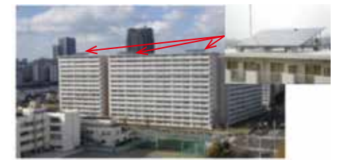
都営住宅への太陽光パネルの設置の例
