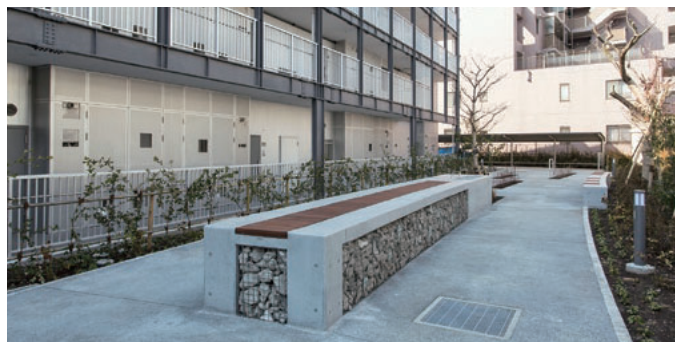
階段室型の住棟に共用廊下を設置 共用スペースに防災テーブルを設置
