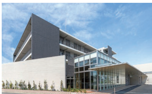
広町住宅 創出地 約4,540㎡ (中野区) ハートテラス中野弥生町
