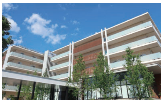
向原住宅 創出地① 約10,000㎡ (板橋区) ケアホーム板橋
