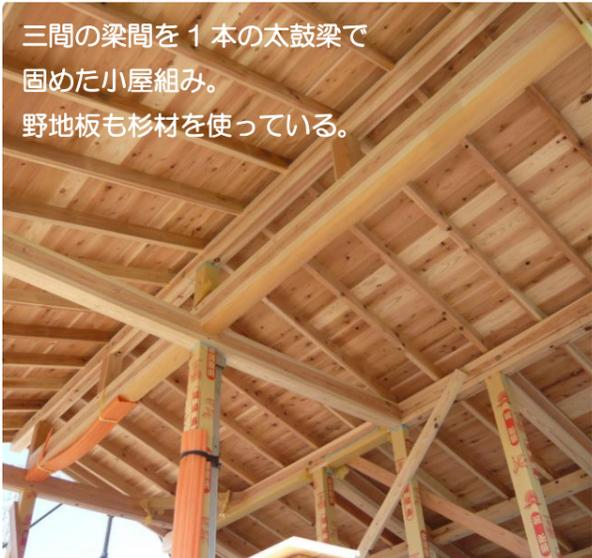
三間の梁間を1本の太鼓梁で固めた小屋組み。野地板も杉材を使っている。
