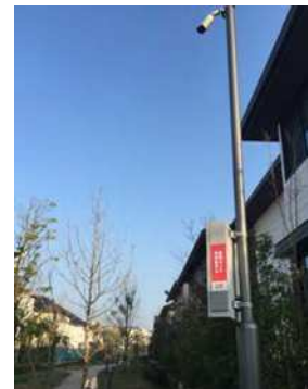
写真Ⅱ.90 遊歩道沿いの街灯に設置された 防犯カメラ
