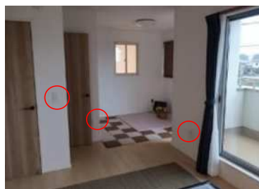
写真Ⅱ.50 主寝室（手前）と一体的に設けられた子ども部屋（奥）。 将来の部屋の分割に備えて、ドアや電気スイッチ・コンセントを配置
