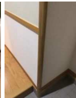
写真Ⅱ.2 出隅の角部へのカバーの 取り付け
