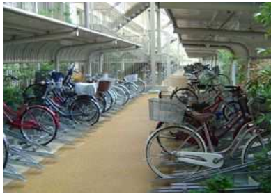
写真Ⅱ.84 平置き・スライドレール型 の駐輪スペース。子どもの使いやすさに 配慮されている
