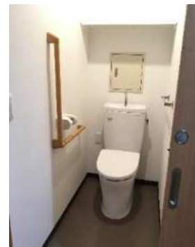
写真Ⅱ.21 トイレの手すりは、立ち座りや子どものトイレトレーニングをサポートしやすい位置に設ける
