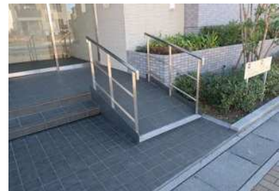
写真Ⅱ.54（右上）、写真Ⅱ.55（右下） ベビーカーでの移動にも配慮された住棟 エントランスに設置されたスロープ
