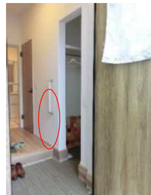
写真Ⅱ.11 上がり框部分に設置された縦手すり
