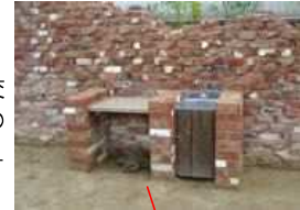
写真Ⅱ.73 居住者の交流のための バーベキュー 設備
