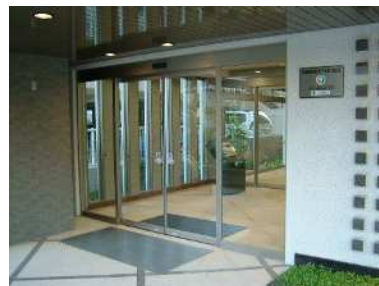
写真Ⅱ.56 注1) オートロック式の自動エントランスドア
