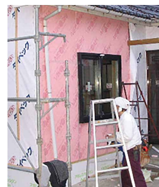
室外から施工
