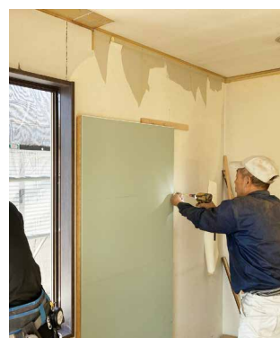
室内から施工②
