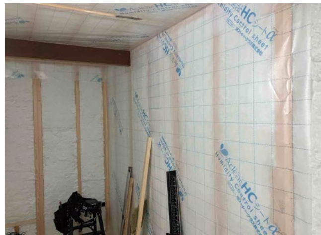
室内から施工①
