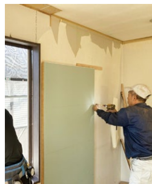
室内から施工②
