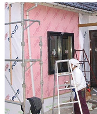
室外から施工
