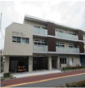
障害者支援施設（世田谷区）
