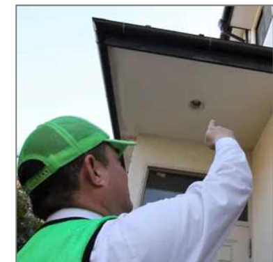
見回り時の目視点検の様子
