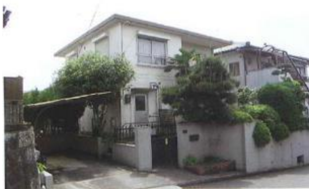
まだ使用できる空き家
