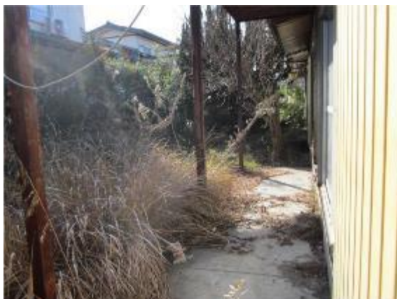
雑草が繁茂した空き家
