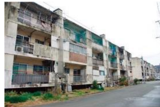
共同住宅の空き家
