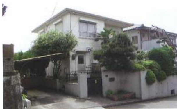
まだ使用できる空き家
