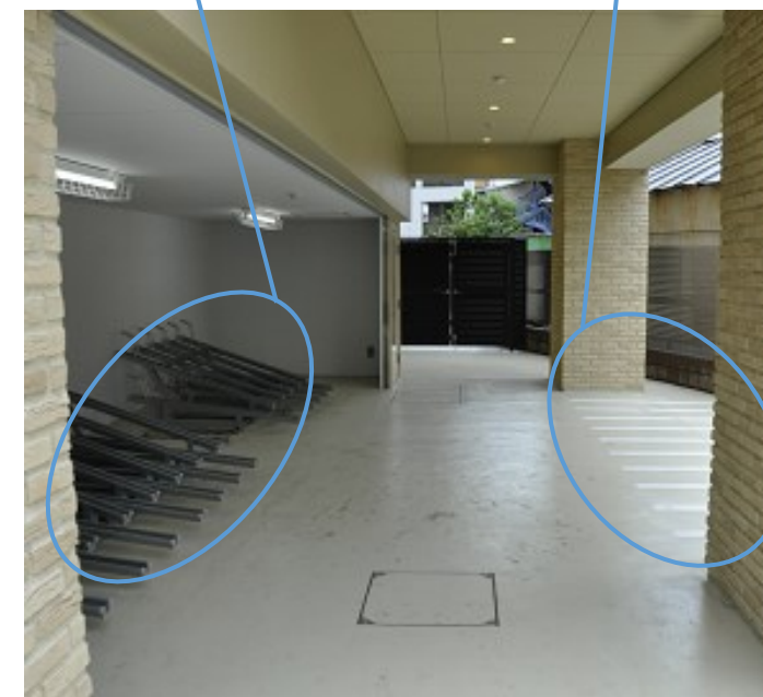
1階ピロティ部自転車スペース
