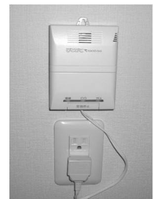
ガス漏れ検知器
