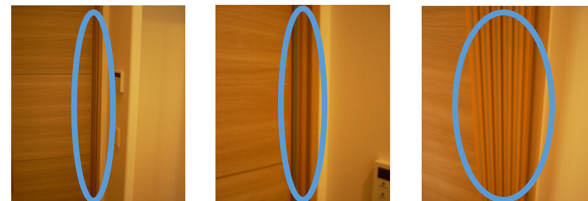
吊元側に後付けの蛇腹状の指挟み防止部品を設置
