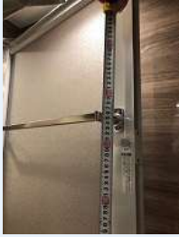
子供が進入できないように 高い位置に設置された浴室錠
