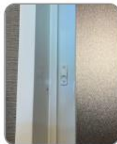
子供の進入を防止する鍵を 1,400mm以上の高さに設置
