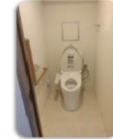
手摺の設置 外開き扉の設置 外部から開けられる鍵を採用
