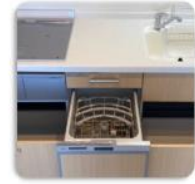
ビルドインタイプの 食器洗い乾燥機を設置
