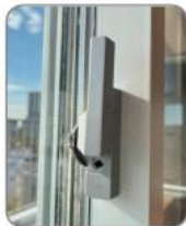
バルコニーに面する窓に 鍵付きクレセントの設置
