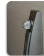
鍵交換をして ディンプル錠を設置
