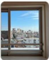
2階以上の窓に 転落防止バーを設置
