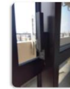
バルコニーに面する窓に 鍵付きクレセントの設置
