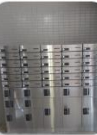
宅配ボックスを設置
