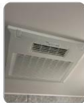
浴室暖房乾燥機を設置
