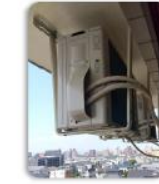
室外機が足掛かりにならない ように、天吊りして設置
