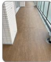
バルコニー床材を防滑性のある 長尺シートに貼替
