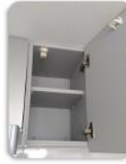
キッチンの棚に 耐震ラッチを設置
