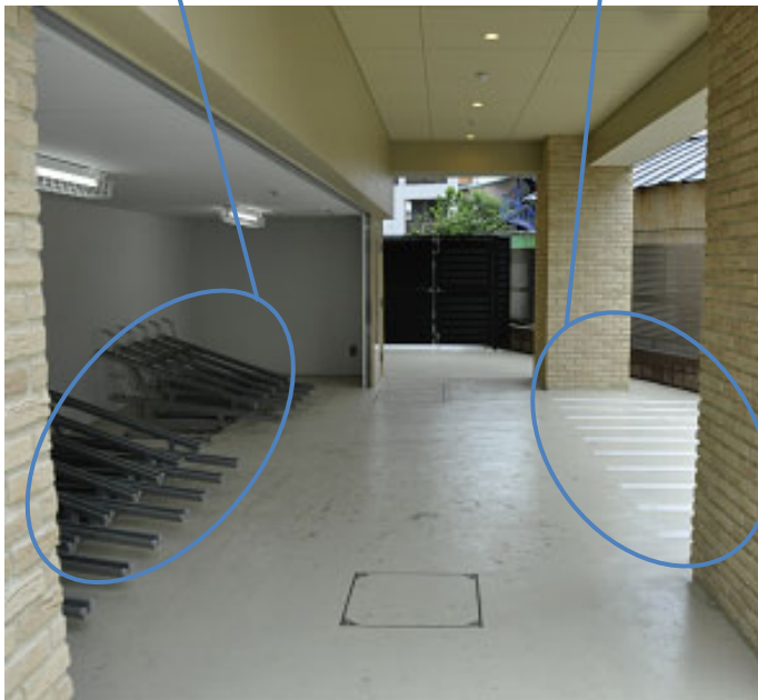
1階ピロティ部自転車スペース
