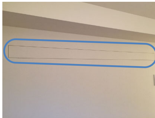
付け長押、長押状壁下地
