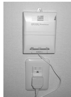
ガス漏れ検知器
