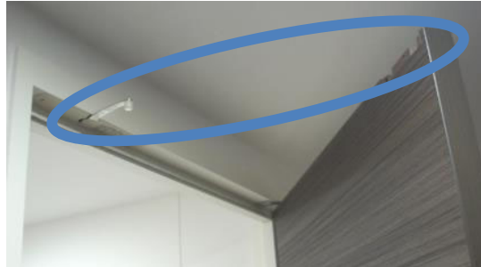
(戸先側の対応) ソフトクローズ機能付き内部建具用ドアクローザー
