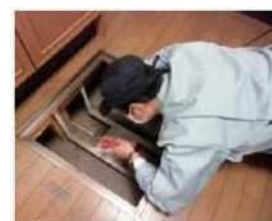
「土台・床組・基礎」調査の様子
