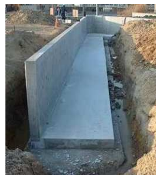
L型擁壁の写真
