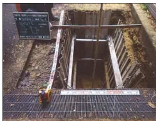
図 12 試掘状況写真
