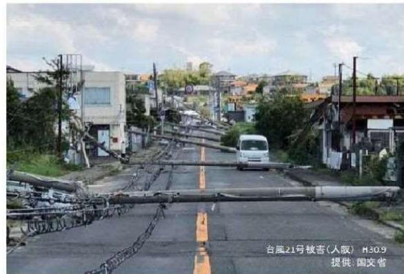
写真1 電線倒壊による被害
