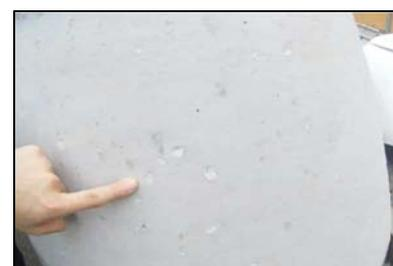
図 11 人孔材料の傷の映像
