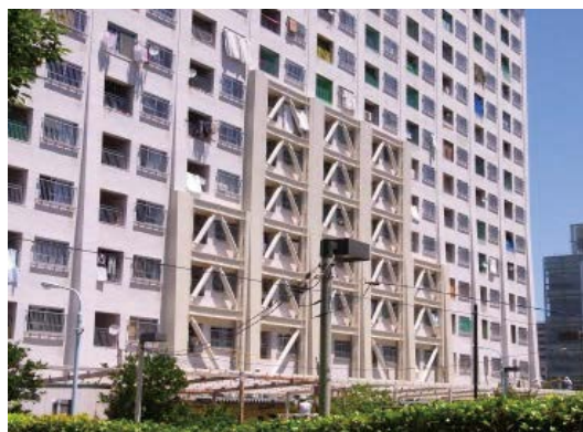
外付け耐震ブレース補強
