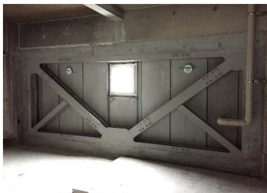
枠組耐震ブレース補強
