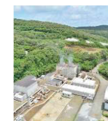
旧八丈地熱発電所
