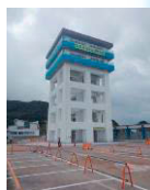
津波避難施設 (新島港)
