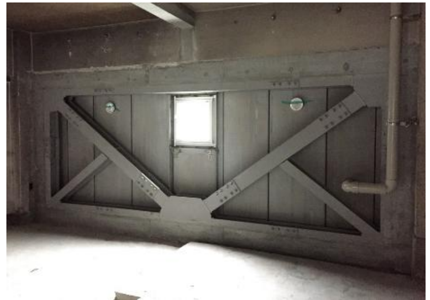
枠組耐震ブレース補強
