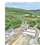
旧八丈地熱発電所
