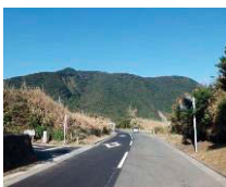
無電柱化 (大島波浮港)
