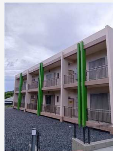
町営粥倉住宅（令和7年度竣工）
