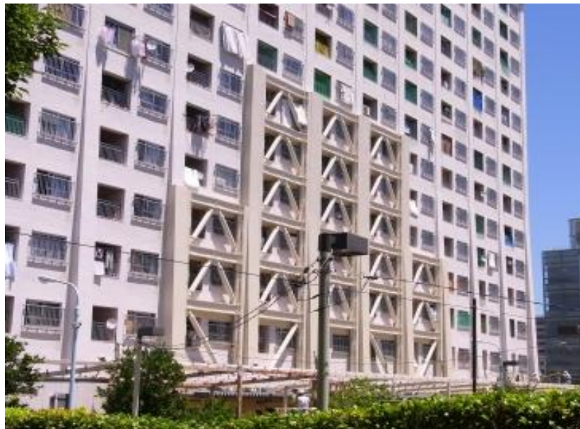
外付け耐震ブレース補強
