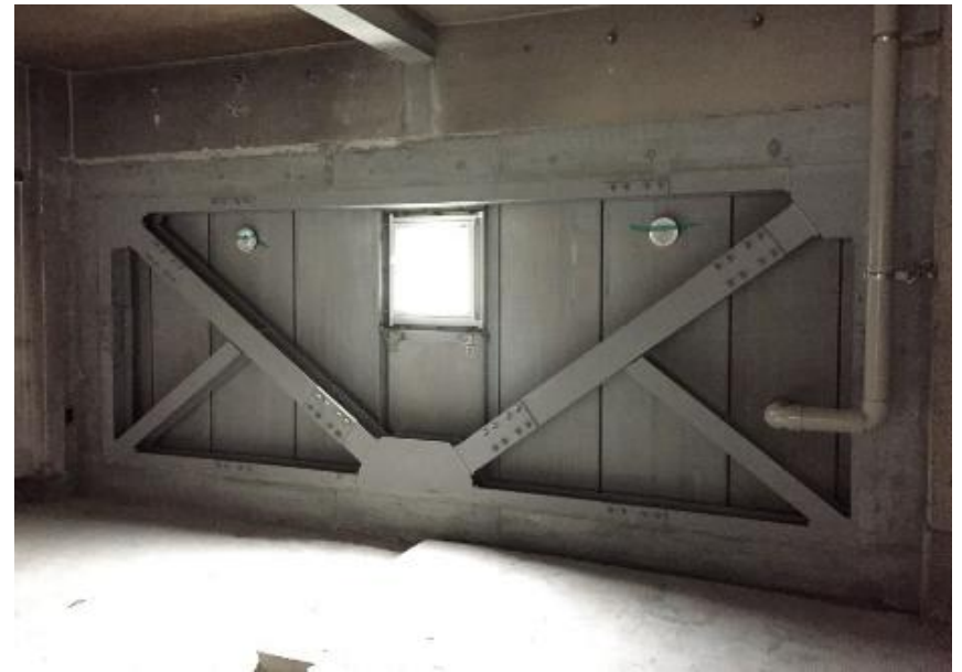
枠組耐震ブレース補強
