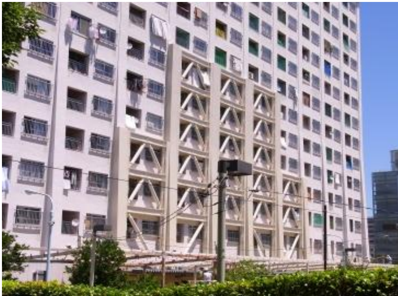
外付け耐震ブレース補強
