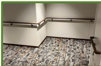
▲手すり設置など転倒防止対策
