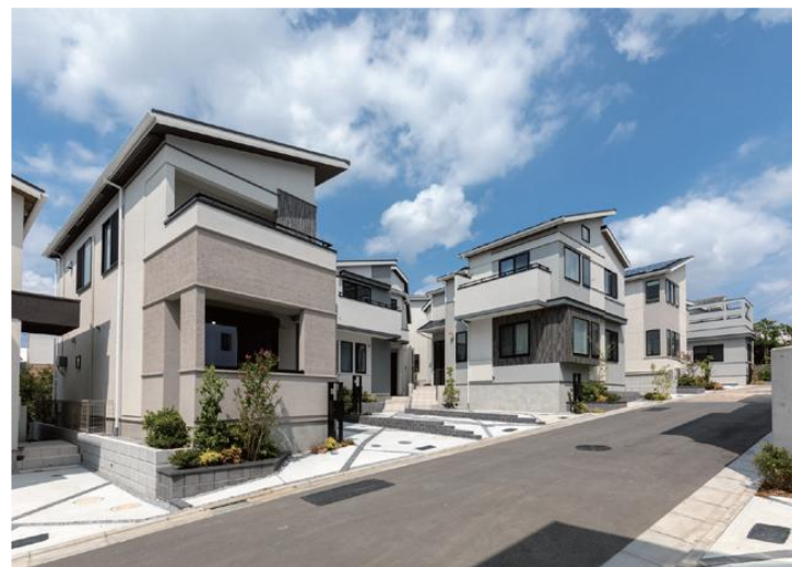
宅地開発における無電柱化の実施事例
