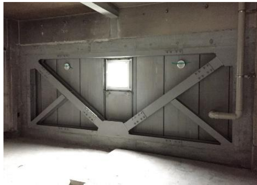
枠組耐震ブレース補強
