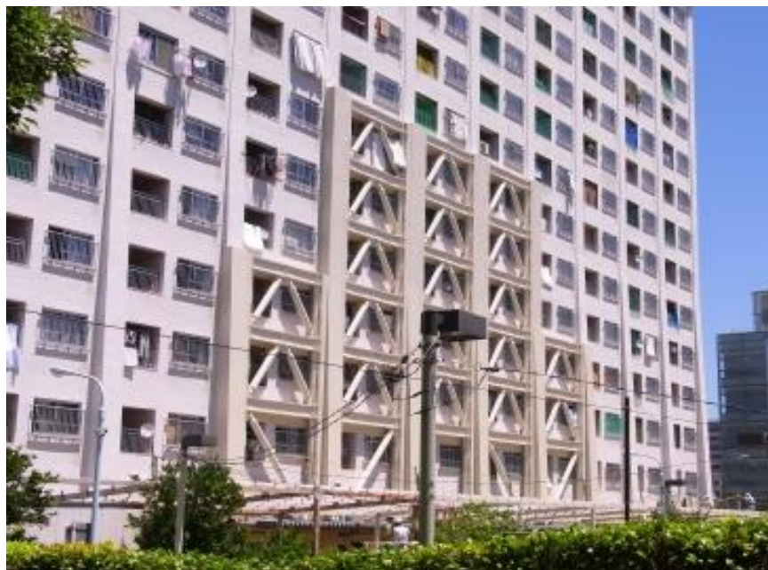
外付け耐震ブレース補強
