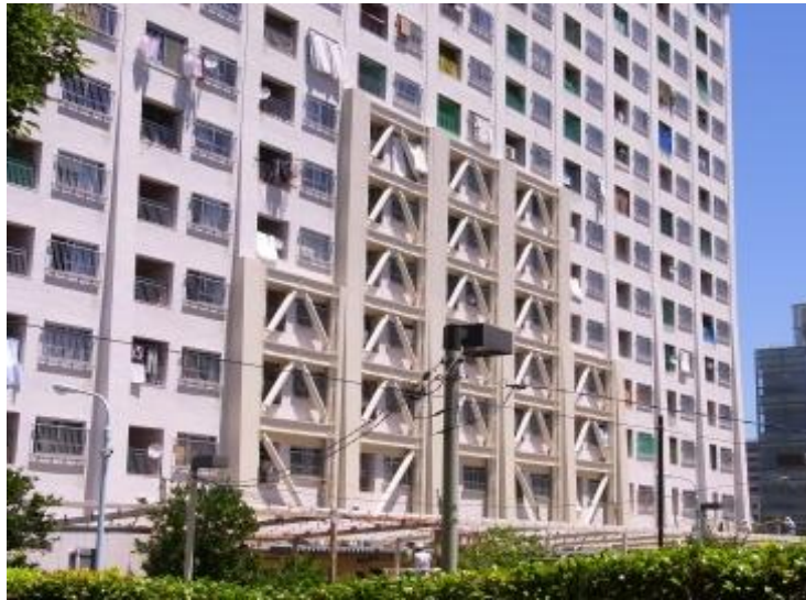
外付け耐震ブレース補強
