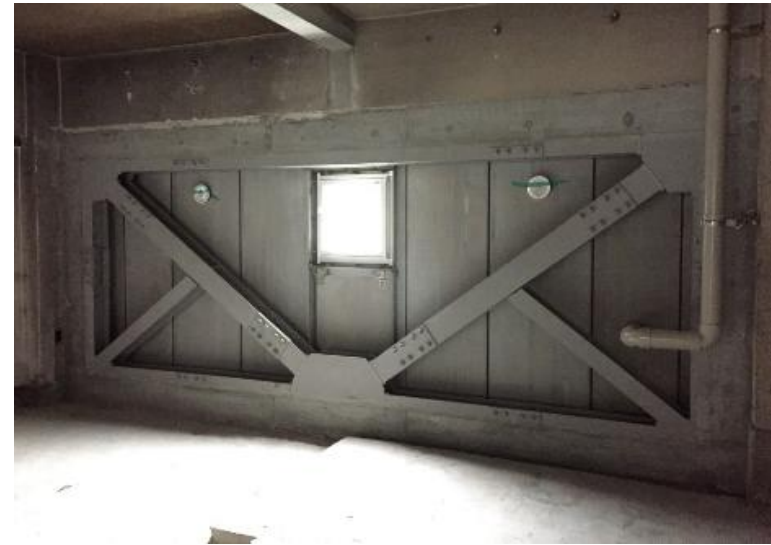
枠組耐震ブレース補強
