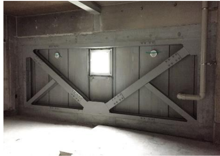
枠組耐震ブレース補強
