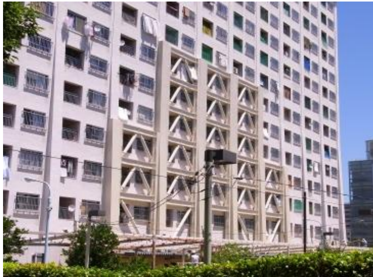
外付け耐震ブレース補強
