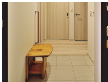
段差の解消された玄関
