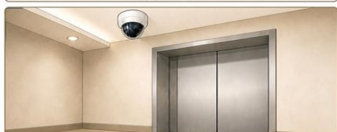
エレベーターホール
