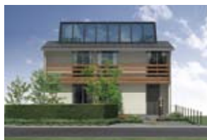
柱や梁に多摩産材を使用し、暖房に太陽熱を利用
