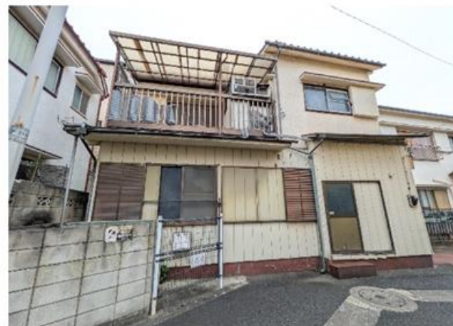
< 建物外観（改修前） >
