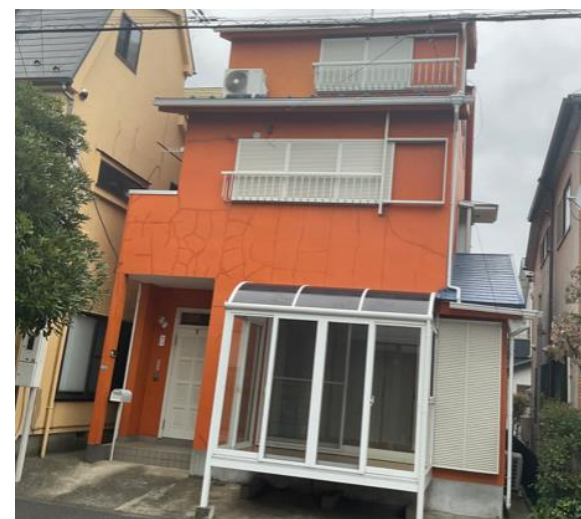
<建物外観（改修前）>
