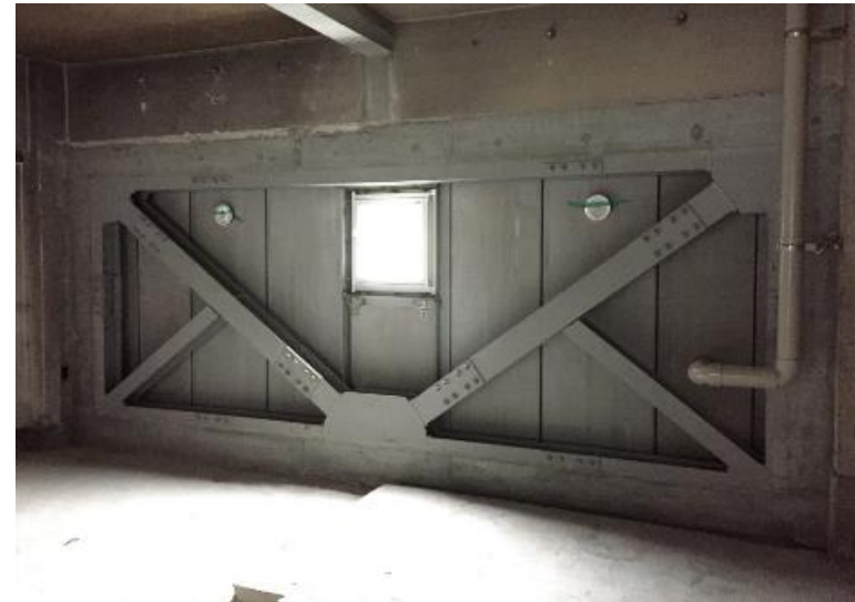
枠組耐震ブレース補強
