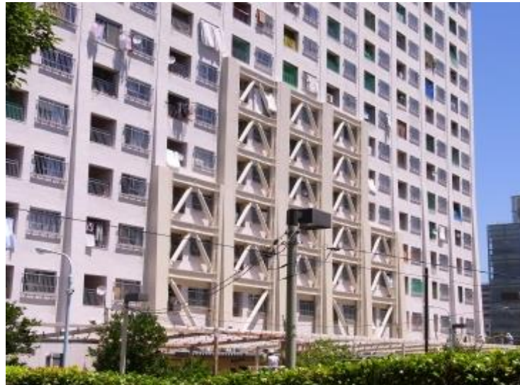
外付け耐震ブレース補強
