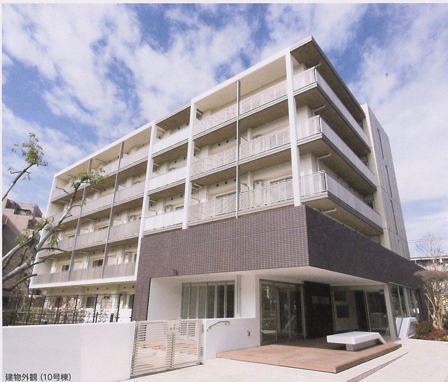
建物外観（10号棟）
