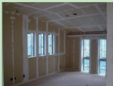
壁の断熱改修（断熱材の充填）
